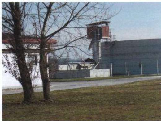
Pogled na postrojenje za separaciju gnojnice
